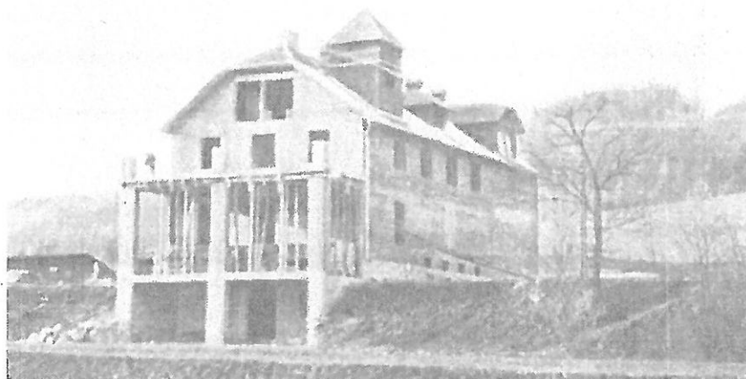
Fot. 25. Budynek Podhalańskiej Spółdzielni Owocarskiej w Tymbarku, powiat Limanowa.
