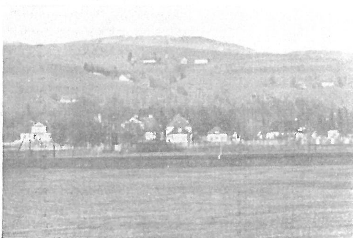
Fot. 6. Ogólny widok budynków szkolnych.
